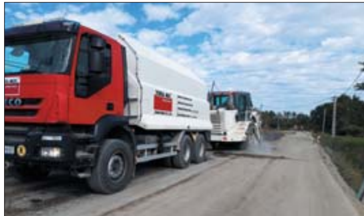
Bekötőút-építés osztrák géplánccal
