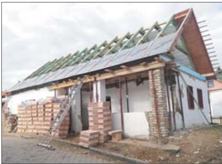
Már a tetőfedést végzik a felújítás alatt álló tájház és kézműves műhely épületénél.
