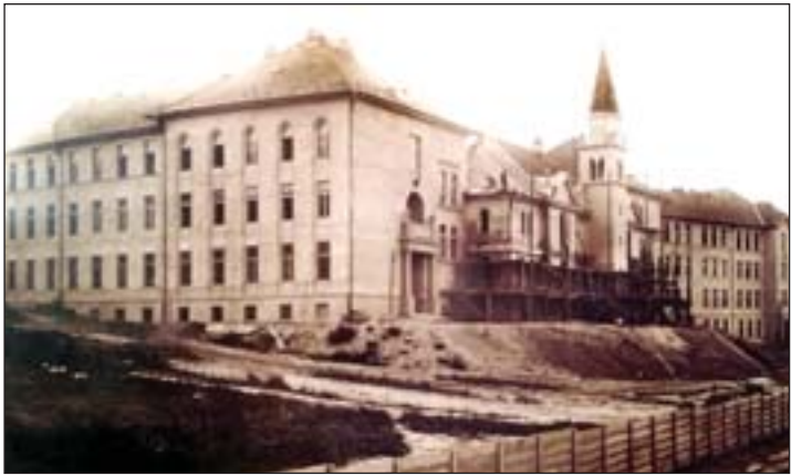
A Notre Dame zárda építés közben.
