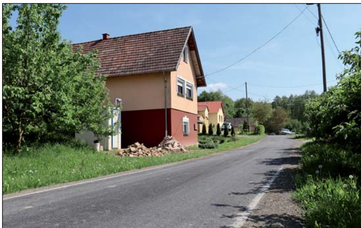
A zártkerti út egy részét aszfaltossá teszik
