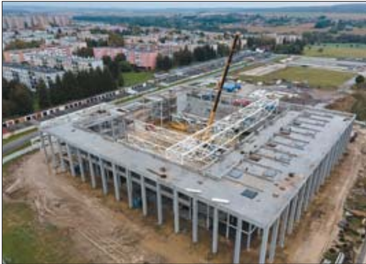
Az épülő rendezvénycsarnok
