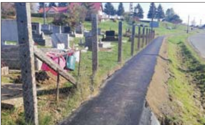
A budafai temető melletti felújított járdaszakas
