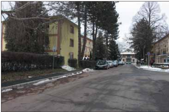
A járdafelújítás a lakótelepet is érintette
