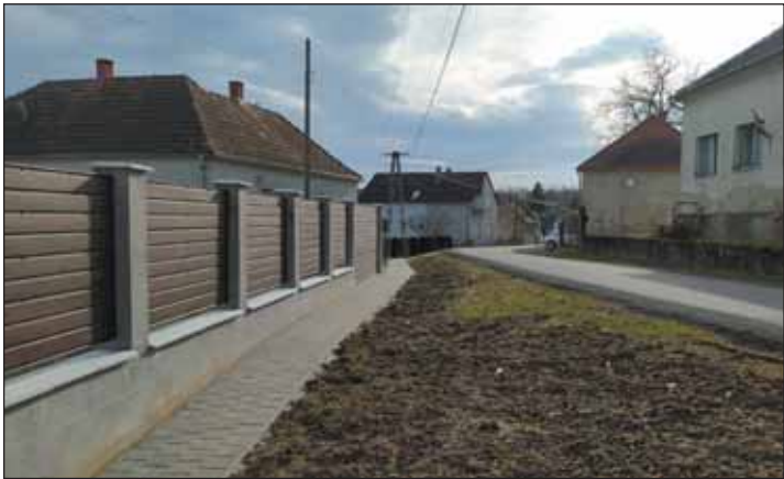
Járdafelújítás és aszfaltozás a Hunyadi utcában
