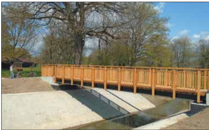
Elkészült az új híd
