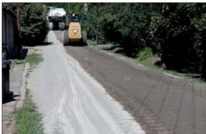
Elkezdődött a Dózsa utca rekonstrukciója
