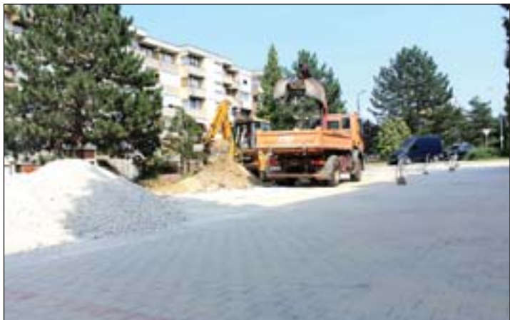
A Hegyalja utca 59–65. számú tömbbelső átépítése.
