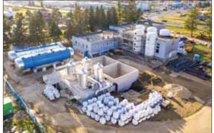
A keleti ivóvíztisztító építése az idén befejeződik
