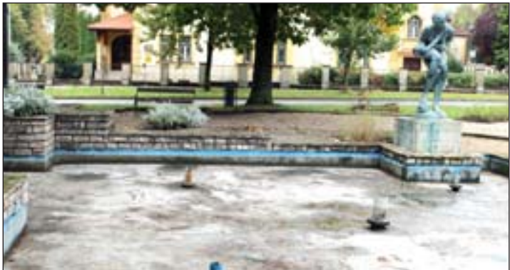
Felújítás előtt a Kis makrancos.
