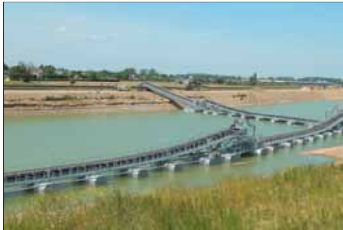
Úszó szállítószalagok Belgiumban.
