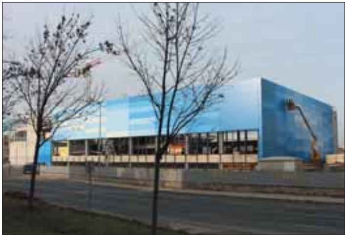
A zalaegerszegi új uszodánál már a homlokzati elemeket rakják.
