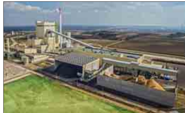
A dunai vízvárosi hő- és villamos erőmű.
