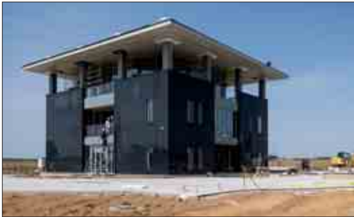
A ZalaZONE irodaépülete még kivitelezés alatt.
