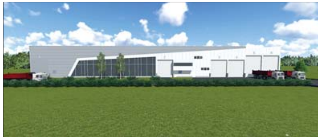
Épülő hulladékfeldolgozó üzem, Zalaegerszeg.
