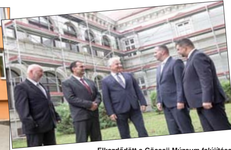
Elkezdődött a Göcseji Múzeum felújítása a Modern Városok Program részeként.
