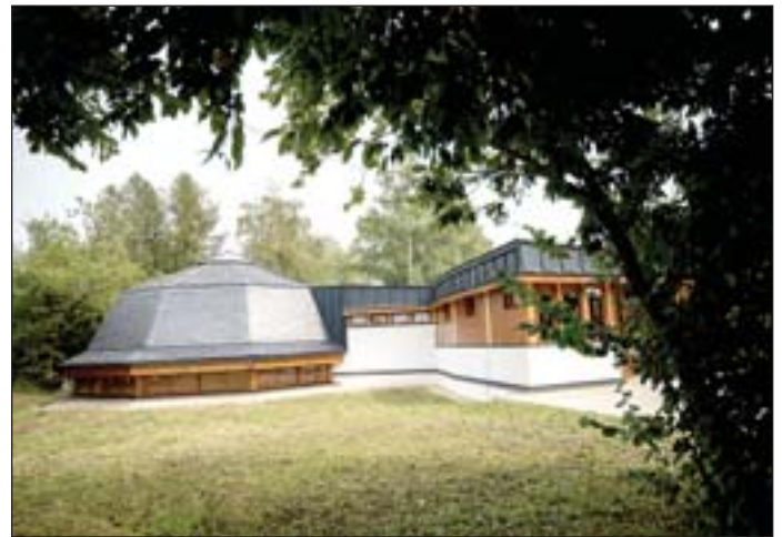
Befejeződött a Kézművesek Házának bővítése.
