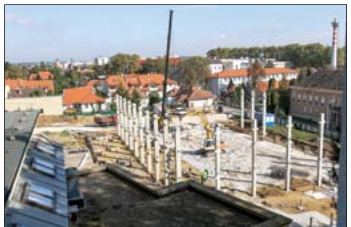
Sportcentrum, vívócsarnok épül a Mindszenty-iskolában, a Zárda utcában.
