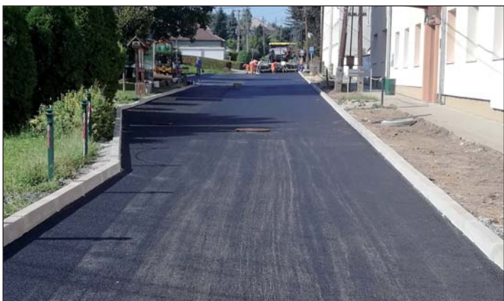
A kötőréteg aszfaltozása a Rákóczi utcában
