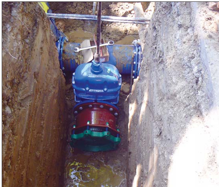
Ivóvízvezeték-szakaszolási lehetőség kialakítása.
