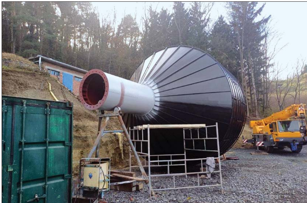
Az egervári ivóvízmű víztornyépítése.
