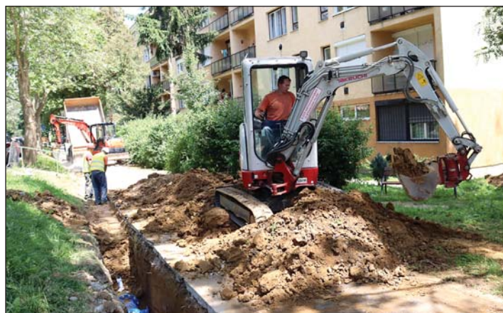
Új ivóvízvezetékét fektetnek a Landerhegyi úton.
